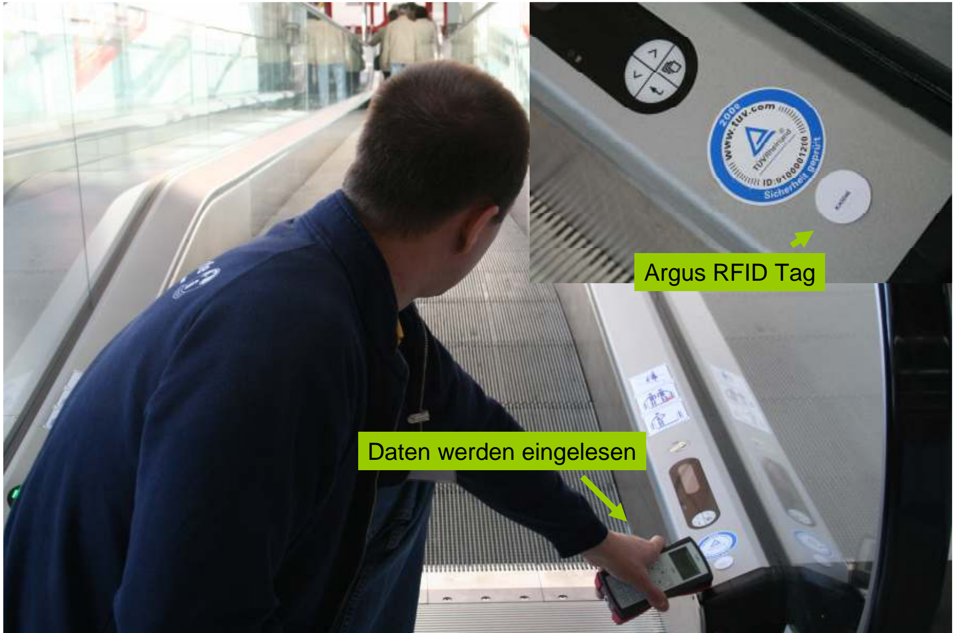
Wartung und Kontrolle einer Rolltreppe
